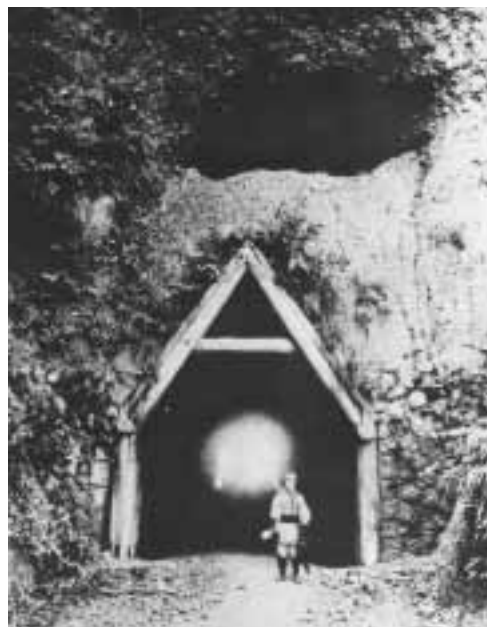
八箇峠のトンネル
