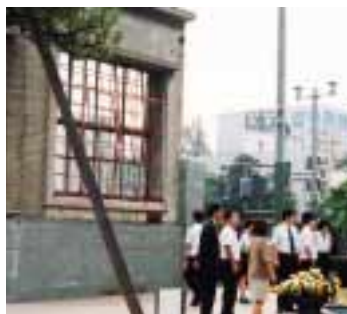
原爆病院前には爆風で曲がった鉄製の窓枠が保存されています
