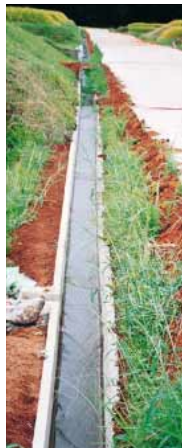
農道・水路の改修（安養寺）
