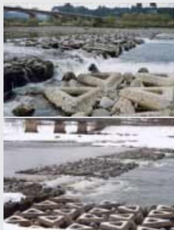
●改修前(写真上)と改修後(写真下)の十日町橋下流の床固
