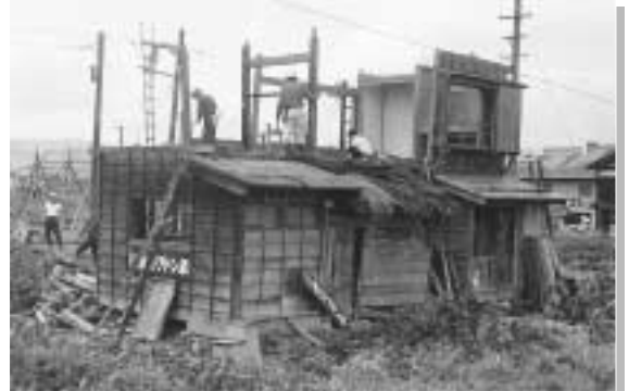
二階を吹き飛ばされ全壊した家屋 第二室戸台風により災害救助法の適用を受けました。死傷者7人、家屋の全半壊162棟、被害総額1億9千7百万円でした。
