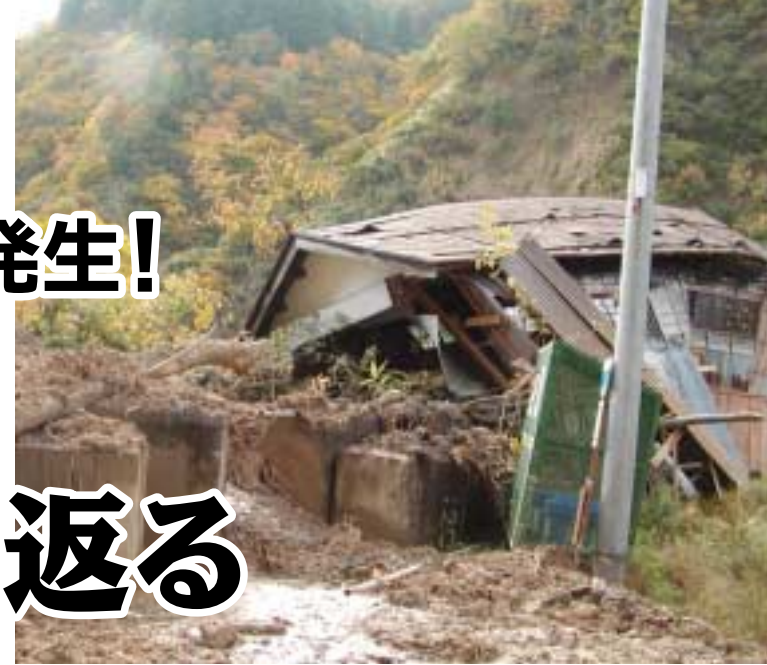
中越大地震で発生した二ツ屋地区の地すべり
